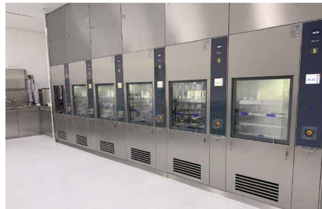
*Die bauliche Trennung der unterschiedlichen Zonen durch Aufbereitungsgeräte bedingt, dass die Medizinprodukte auf der einen Seite (rote Zone) kontaminiert in die Reinigungs- und Desinfektionsgeräte (RDG) eingeschoben werden und auf der anderen Seite nach erfolgreichem Programmablauf in der gelben Zone in sauberem Zustand entnommen werden können.*
