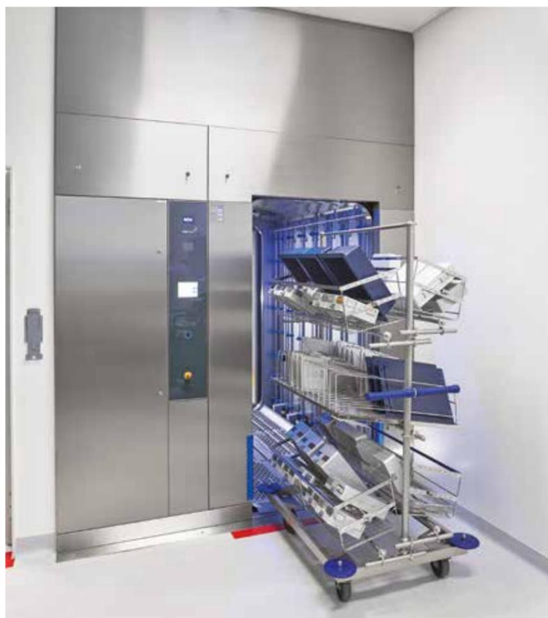
*Die bauliche Trennung durch die Container-Waschanlage (CWA) ermöglicht es, dass die Container und/oder iso-Modul-Wannen auf der einen Seite (rote Zone) kontaminiert in die CWA eingeschoben werden und auf der anderen Seite nach erfolgreichem Programmablauf für Reinigung und Desinfektion in der gelben Zone entnommen werden können.*
