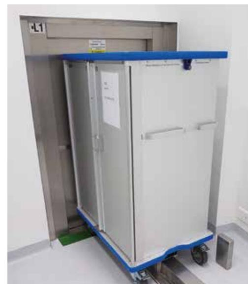
Der mit den bestellten Sterilgütern beladene Transportwagen wird vor der Eingangstüre Transport-System parkiert und durch den automatischen Einzug in den Lift gezogen und in das entsprechende Stockwerk respektive Behandlungszimmer geliefert.
